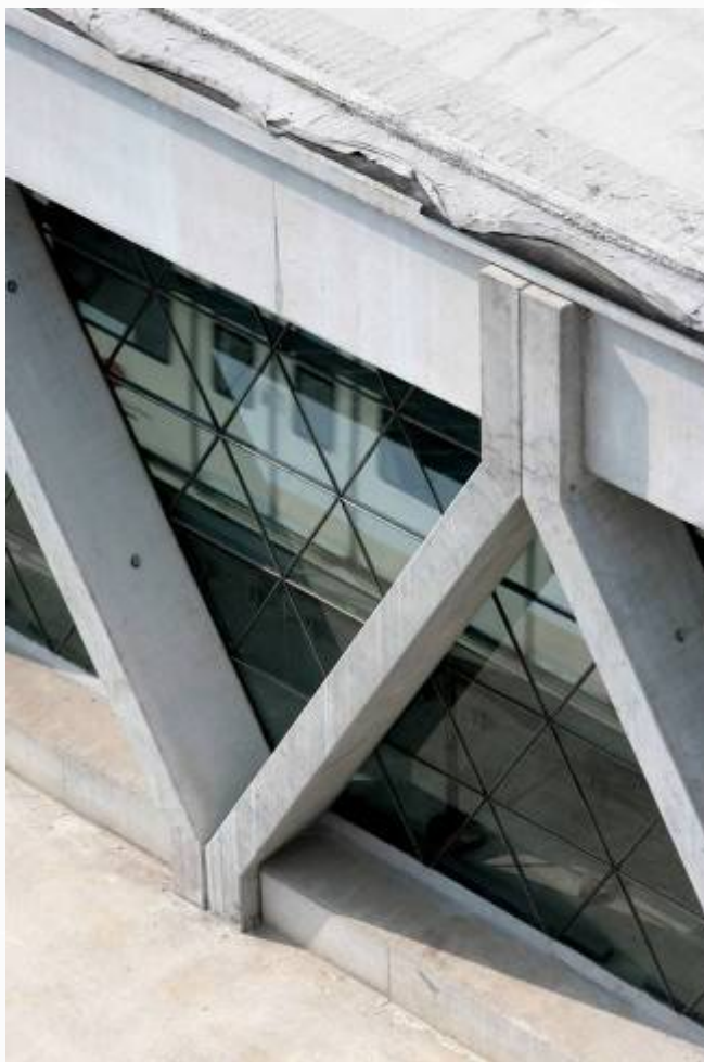
Detalls cobertura vies de Metro (10/03/2010)
