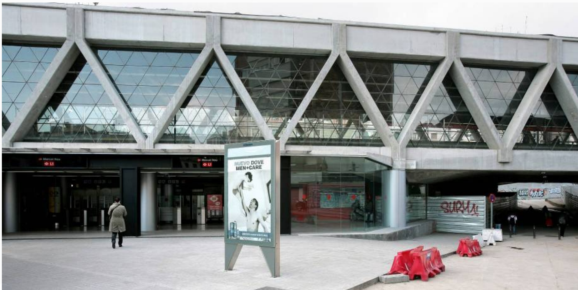
Vista cobertura vies de Metro a l'altura de l'estació de Mercat Nou (10/03/2010)
